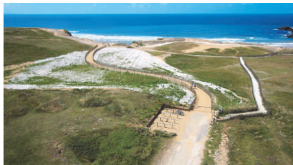
68. La réhabilitation de l'emplacement de l'ancienne aire de stationnement (2007)
