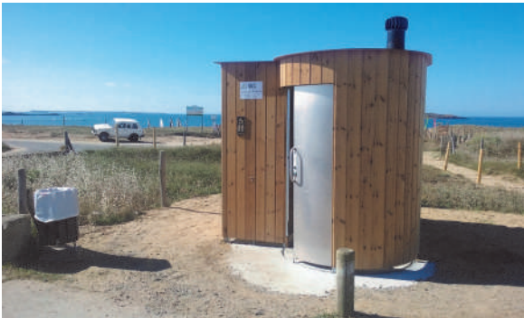
90. Les toilettes sèches sur une aire de stationnement près des plages d'Erdeven
