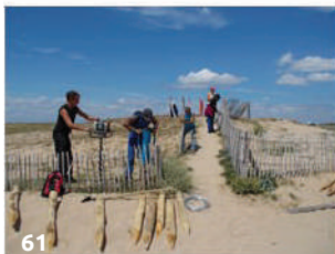
P 57 Travaux de mis en défens par un chantier d'insertion © SMGSGQ
