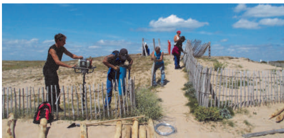
61. La mise en défens d'un espace sensible par un chantier d'insertion
