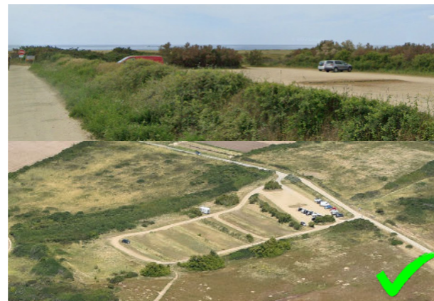
Haies, buttes et revêtement naturel permettent une intégration optimale du parking de Kervégant à Plouhinec.
