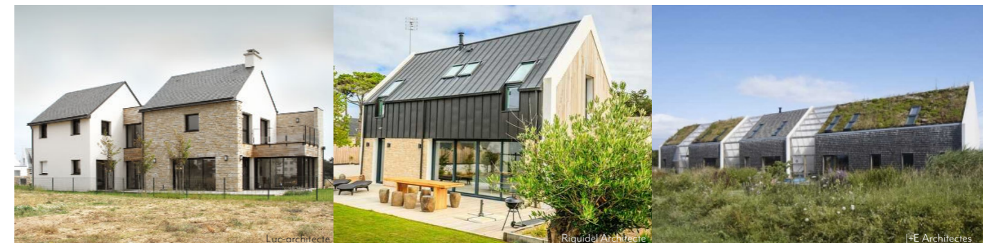
Parement en pierre, bardage en bois, toit végétalisé permettent une intégration optimale dans les paysages des nouvelles constructions. Ces nouveaux projets se sont inspirés de leur environnement naturel et bâti pour proposer de nouvelles structures intégrées. Leurs réinterprétations architecturales ont permis des réalisations contemporaines et modernes tout en proposant une mise en valeur du bâti et une intégration paysagère.
