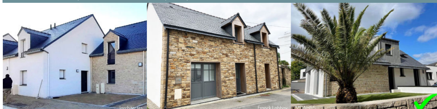
Constructions, extensions et rénovations s'inspirant de l'esprit traditionnel. Leurs réinterprétations du patrimoine architectural et bâti du territoire ont permis des réalisations contemporaines et modernes tout en proposant une mise en valeur et une intégration au paysage alentour.
