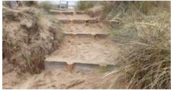
*Reprise des clôtures et pose d'un escalier au niveau du poste de secours de Ste Barbe, Plouharnel (avant/après)*
