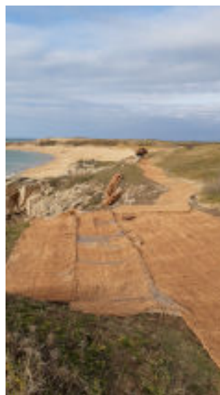
Pose de filets coco à Porh Kerhouet (Erdeven)
