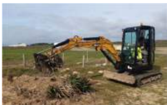
Chantier mécanisé - extraction de yuccas au camping municipal d'Erdeven
