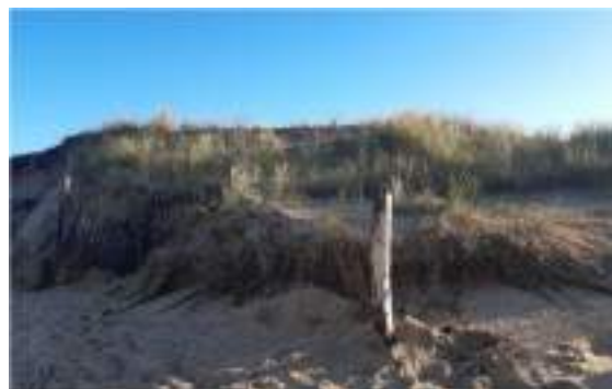
Réparation d'aménagement à la suite d'une tempête à Erdeven
