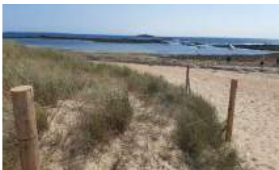
Installation de bi-fil - Roche Sèche à Erdeven
