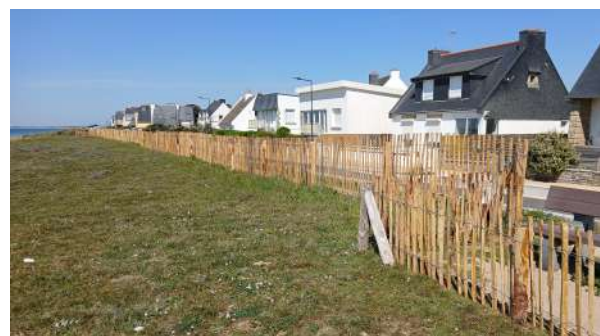
Remplacement des ganivelles sur le boulevard de l'Océan à Penthièvre
